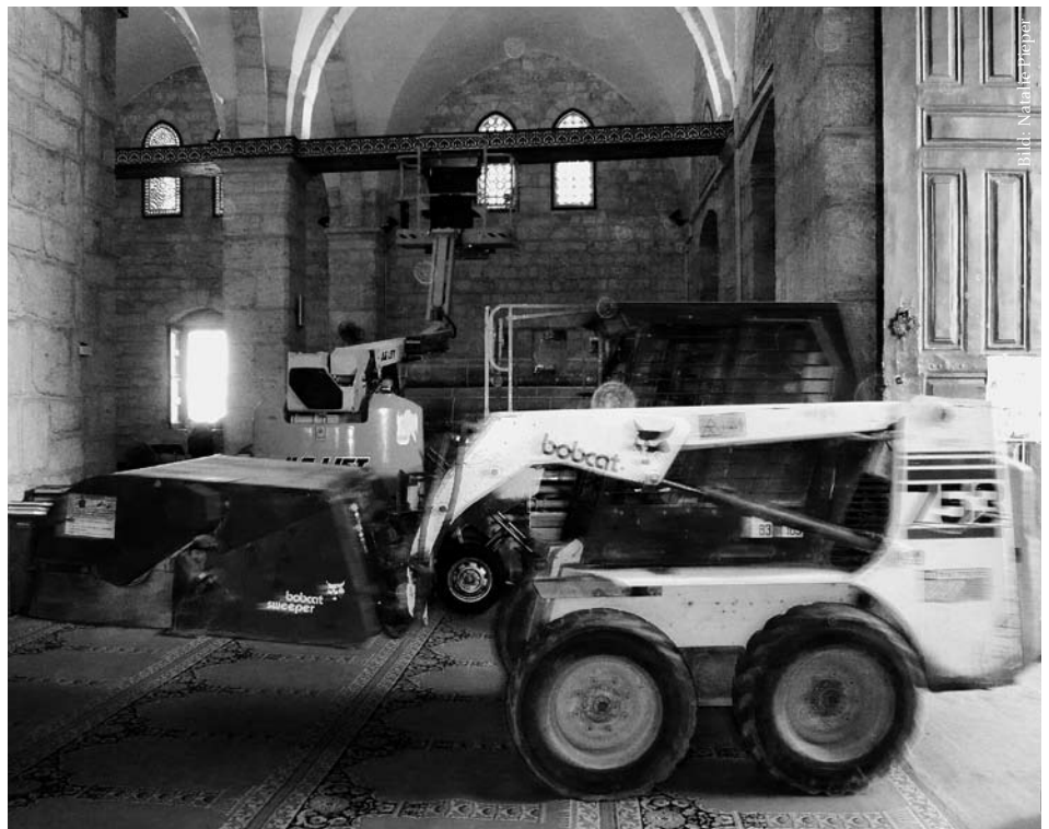
Renovationsarbeiten in der al-Aqsa-Moschee.
